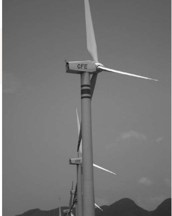
La Venta II wind farm © Comisión Federal de Electricidad "CFE"
